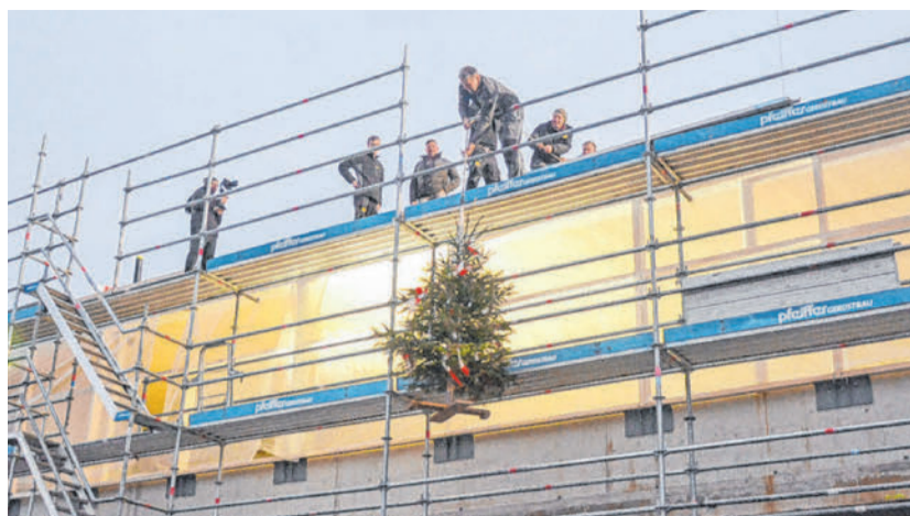
Bei Lustenaus größtem Bauprojekt wurde jetzt der Rohbau fertiggestellt und dieses Ziel mit dem Richtfest gefeiert. BVS
