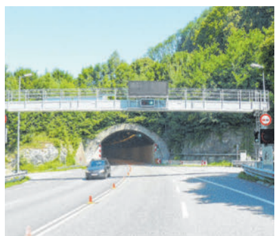
Der Citytunnel in Bregenz wird für Wartungsarbeiten gesperrt.
