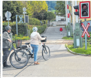
Übergang beim „Gelben Haus am See“ soll aufgelöst werden. VN/GASSER
