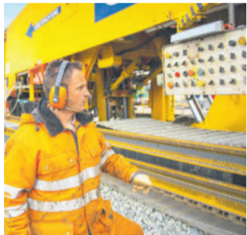
Die ÖBB setzen kommende Woche Spezialmaschinen ein. ÖBB/THURNHER
