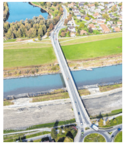
Wasserleitung, Gas, Stromkabel usw. werden für 2,5 Millionen Euro unter das Rheinbett bei der Brücke zwischen Höchst und Lustenau verlegt. LAND VORARLBERG/H. HEIM
