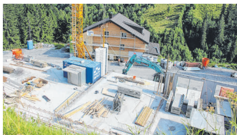
Rund 10.000 Kubikmeter Fels mussten für das Projekt Alpenstolz abgetragen werden. Nun sind die Arbeiten für den Hochbau im Gange.
